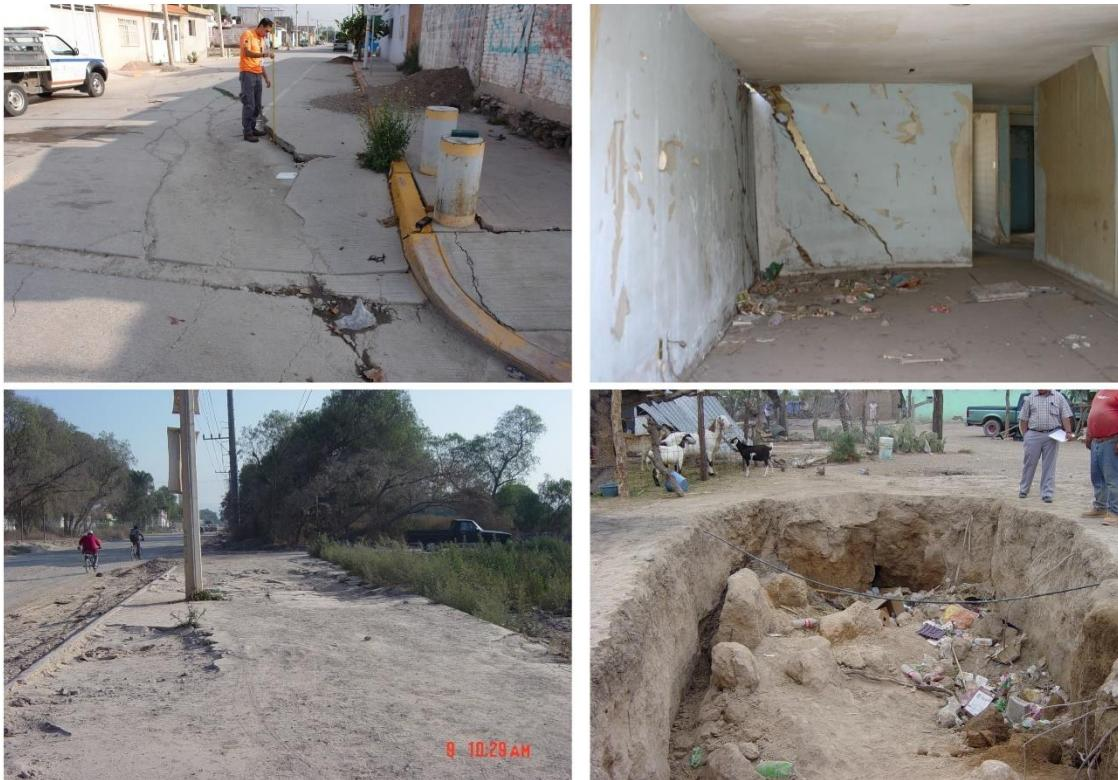
Figura 4. Ejemplos de daños a la infraestructura causados por agrietamientos y hundimientos en San Luis Potosí.
