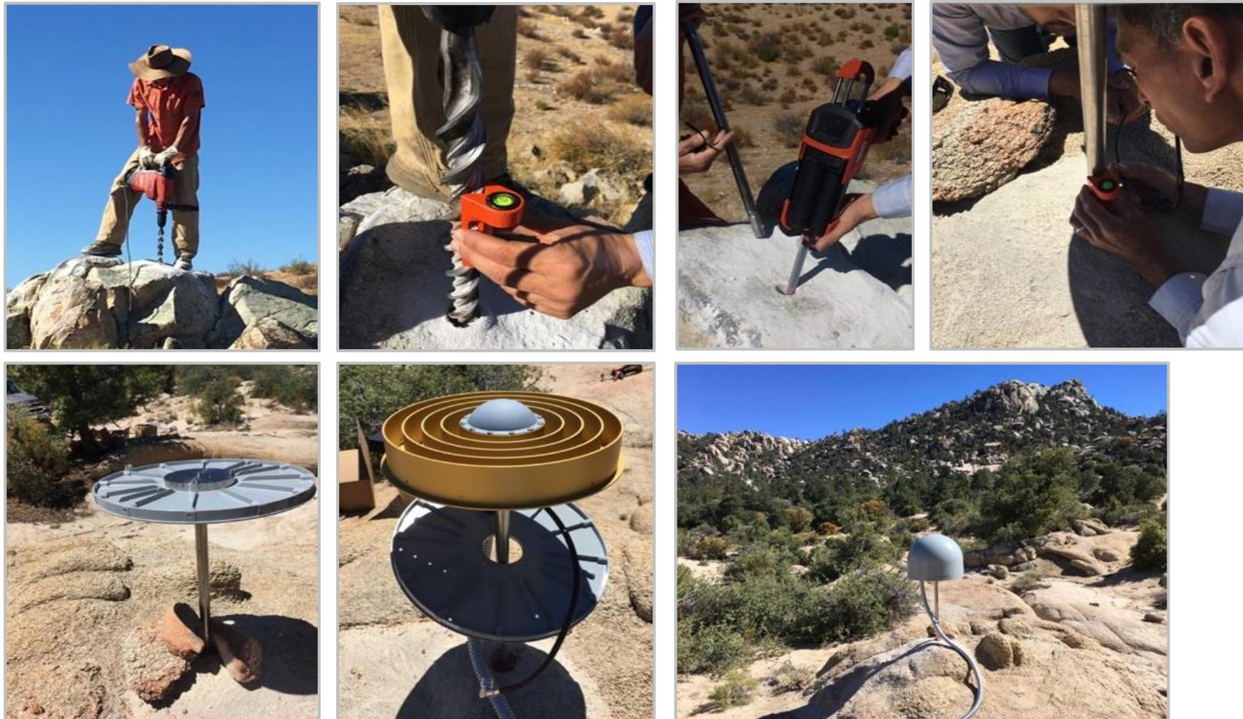
Figura 5. Proceso de construcción de monumento con mástil de acero inoxidable empotrado en roca en la estación sismológica del Rancho San Luis en Sierra Juárez, Baja California.
